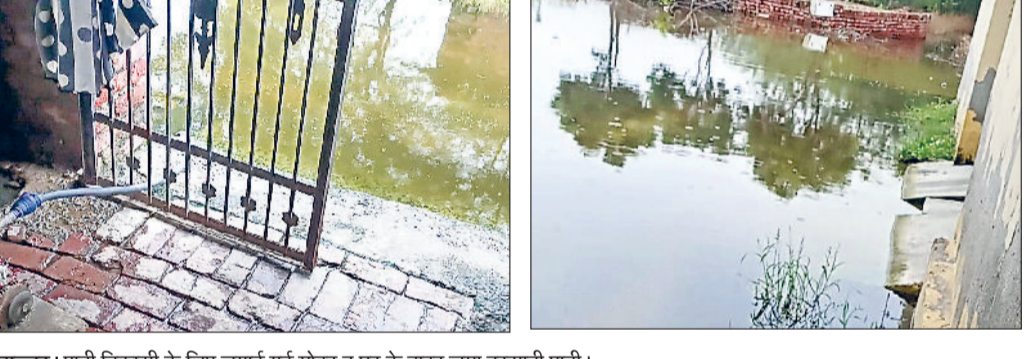
झज्जर। पानी निकासी के लिए लगाई गई मोटर व घर के बाहर जमा बरसती पानी।
